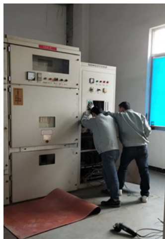
大陸吳江廠區所屬供電局檢查發現，廠內直流屏無法正常使用，提出整理改善。在 1 月份於廠商施工，經供電局驗收確認後通過。
