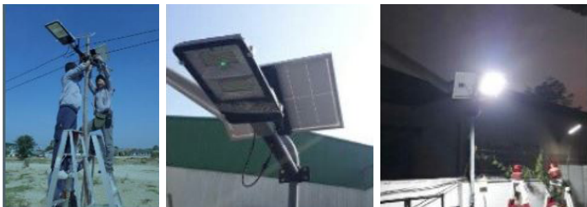
泰國廠於走道安裝太陽能板，節省用電量
