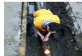
地下漏水管路查找修復
